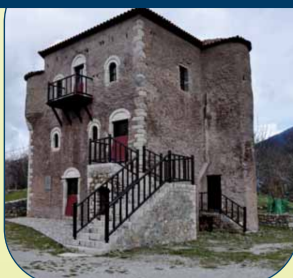
Πυργός Πετμαζίων σαν οικισμό των Λουσσών Petmeza family tower at Lousoi village
